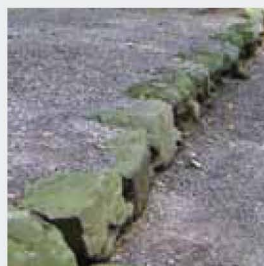
23. Leveling Stone Base
